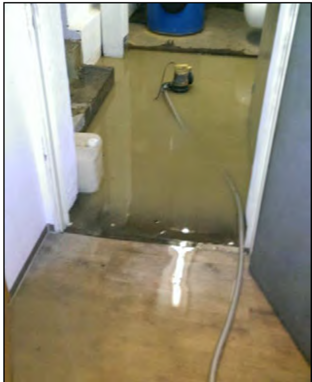
Wasser überall. Mit Pumpen- und Muskelkraft wird gesaugt und geschippt.
